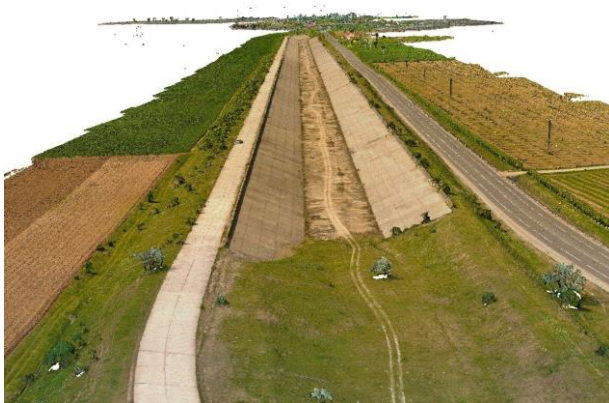
(a) canalul magistral, cu digurile și drumul de serviciu — culori reale
