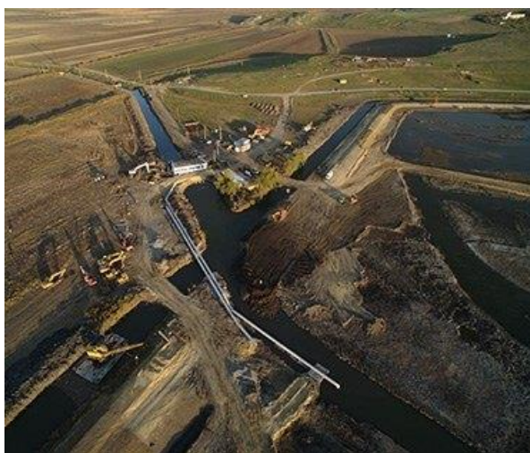
(a) lucrări la un canal, fotografiate cu drona
