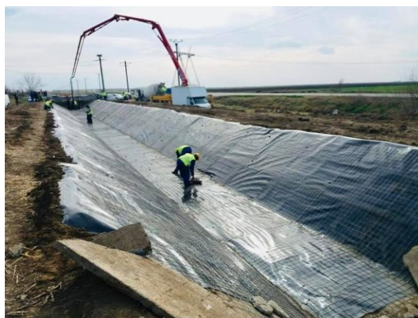
(b) impermeabilizarea taluzurilor unui canal
